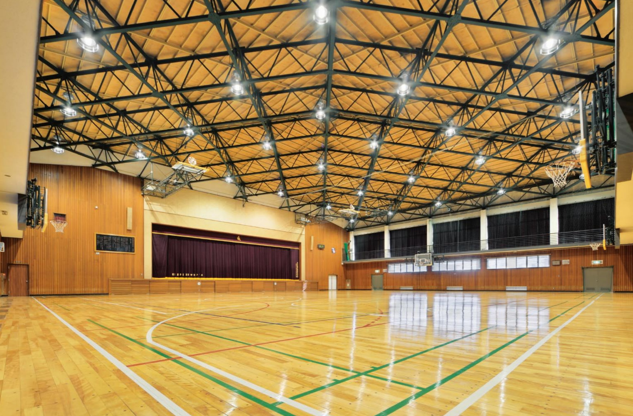
様々な用途に使用される体育館を高効率・高演色性のFECセラルクスエース360Wで照らし出し、均斉度の高い視環境を創出している。 A visual environment that is highly and well balanced is created in this multi-purpose gymnasium by illuminating it with highly efficient, good color rendering 360W EYE CERA ARC ACE lamps.
